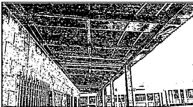
Foto 4: Corredor de las 3 aulas descritas anteriormente
